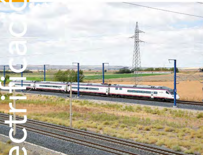
Dos tipos de catenarias. Catenaria tipo GIF (LAV La Sagra-Toledo) y, en primer plano, catenaria NAFA (LAV Madrid-Sevilla). (La Sagra).
