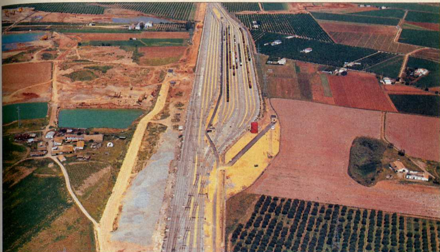
La nueva estación de ordenación de composiciones de Majarabique ha constituido una de las principales actuaciones de la RAF de Sevilla. / PAISAJES ESPAÑOLES
