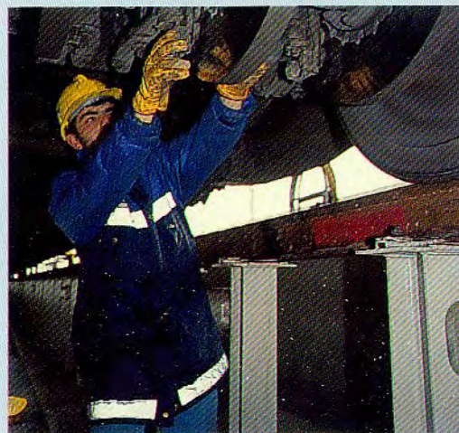
FOTO. INSPECCION DE DISCO DE FRENO.
