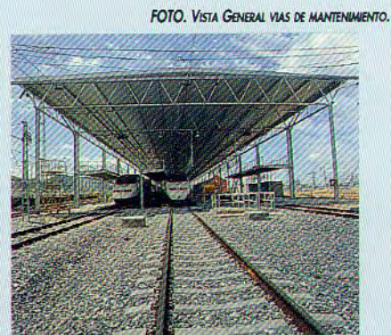
FOTO. VISTA GENERAL VIAS DE MANTENIMIENTO.
