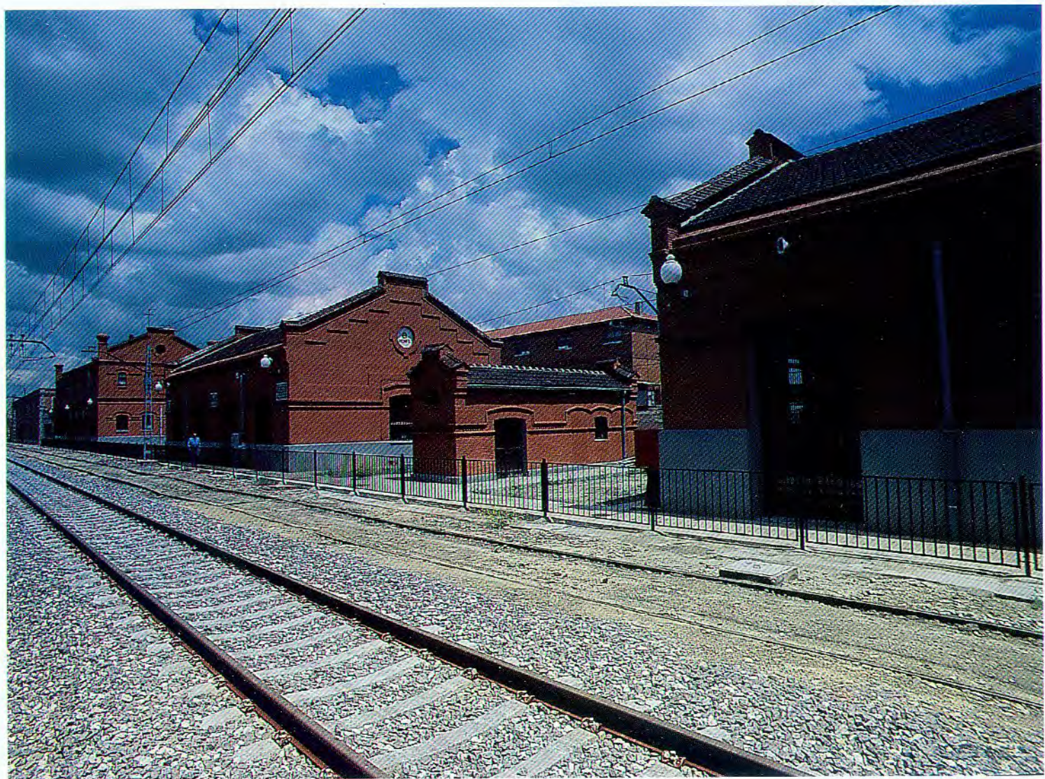
FOTO. EDIFICIOS REHABILITADOS.
