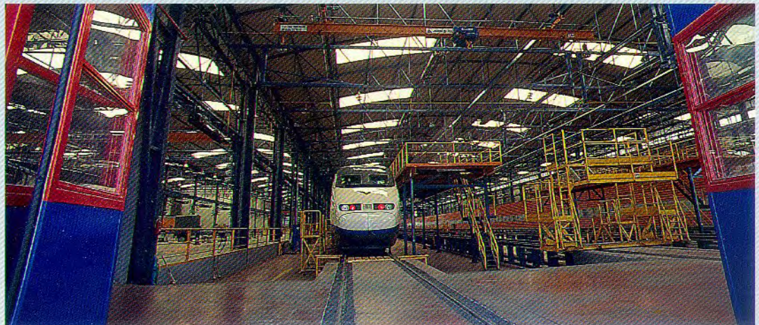
FOTO. LA SAGRA: VISTA GENERAL NAVE DE VIAS.
