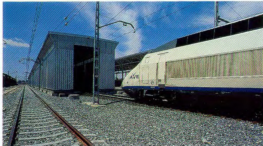
FOTO. ENTRADA AL TUNEL DE LAVADO.
