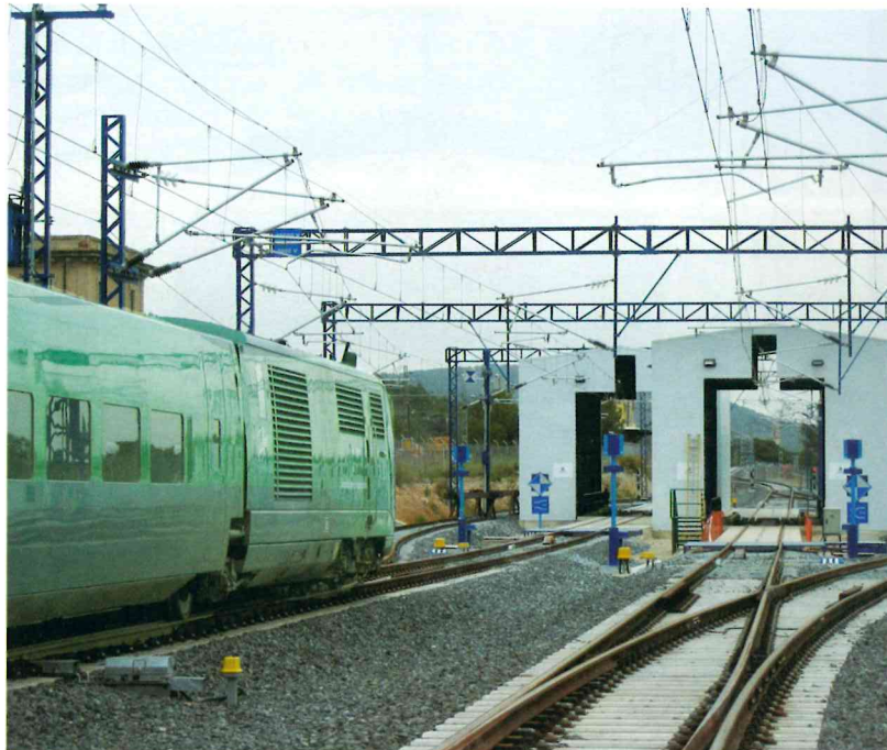
Gracias a los nuevos cambiadores de ancho (en la foto los dos cambiadores duales de Roda de Bará) y a los trenes de ancho variable (en la foto el tren ascultador de Adif) es posible extender los beneficios de la alta velocidad al conjunto de la red. De hecho, el tren Talgo diésel de la foto podría circular por toda la red ferroviaria europea, desde Algeciras a Estambul, por ejemplo.
